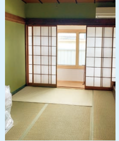
内装、エアコンなどの整備
