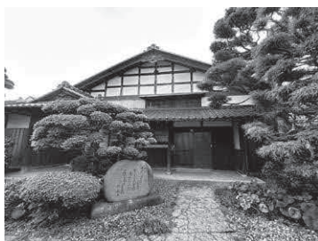
修繕を実施する山川登美子記念館
