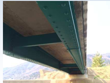
播川橋（補修後）
