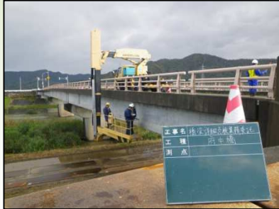
橋梁点検車による点検
