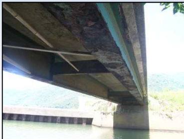
播川橋（補修前）
